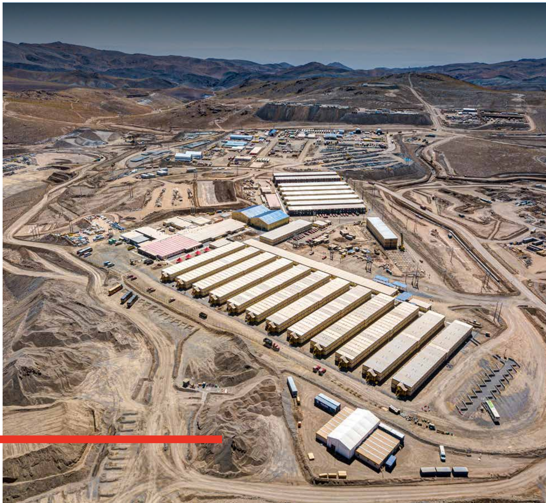
QUEBRADA BLANCA FASE 2 . CAMPAMENTO CONCENTRADORA
