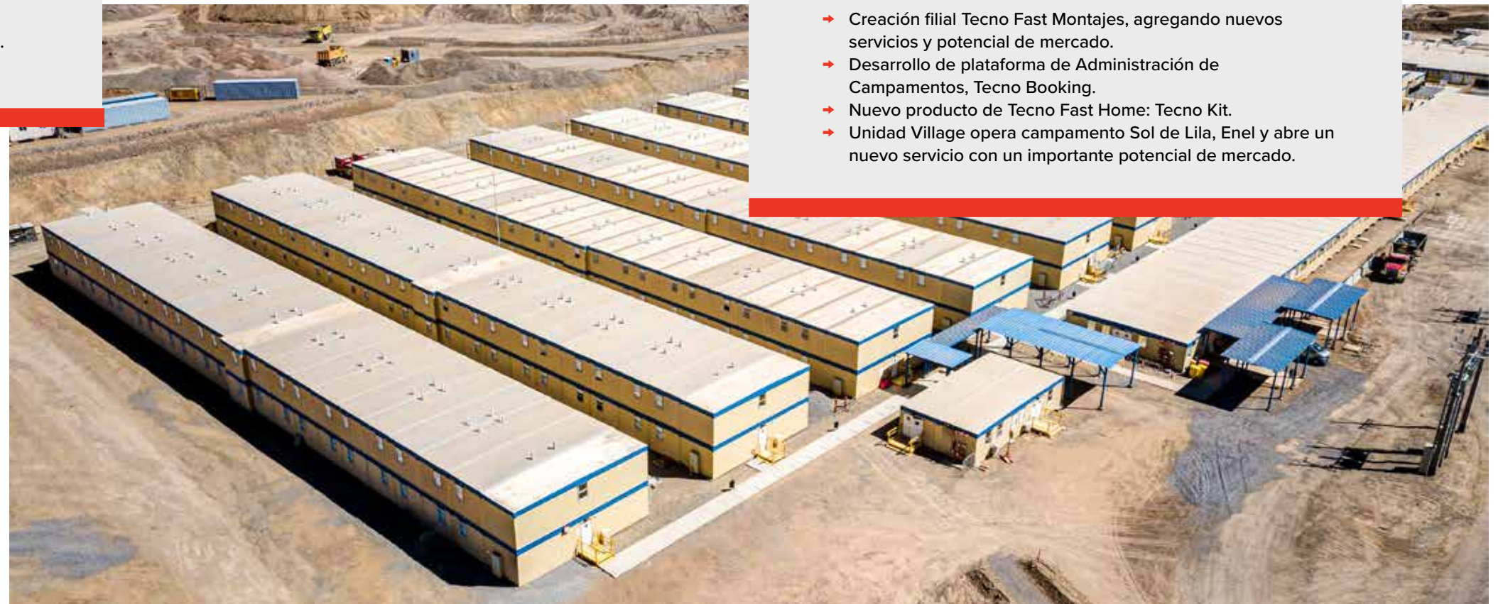
QUEBRADA BLANCA, CONCENTRADORA - CHILE
