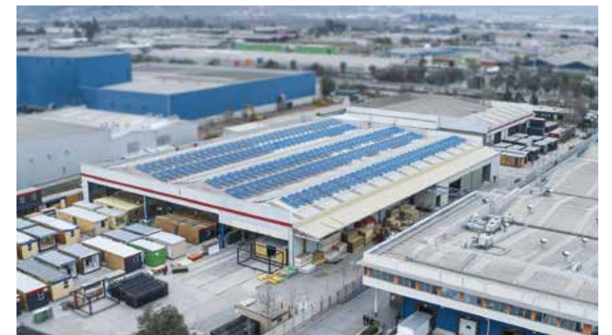
INSTALACIÓN FOTOVOLTAICA EN PLANTA LA MONTAÑA - CHILE
